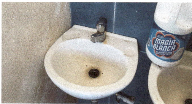
Foto 15: Instalación de lavamanos.
