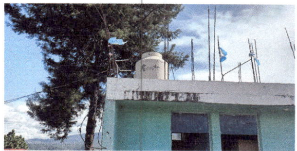
Foto 12: Sustrucción de depósito de agua 1250 lt.
