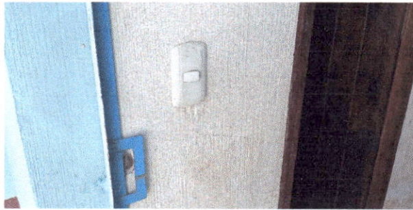
Foto 9: Sustrucción de inerruptores simples.
