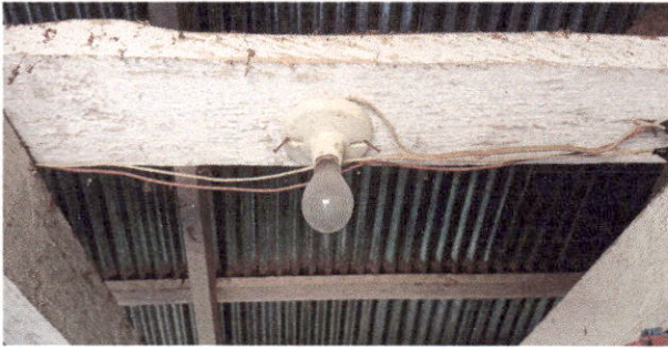
Foto 7: Sustrucción de focos ahorradores.
