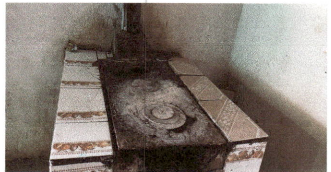
Foto 16: Sustitución e instalación de plancha de metal de 3 hornillas.
