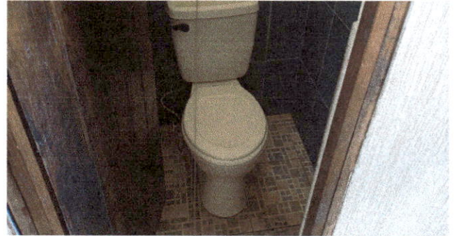
Foto 14: Instalación de inodoro.
