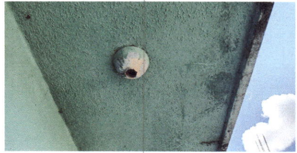
Foto 8: Sustrucción de plafoneras.
