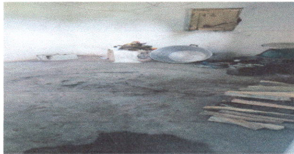
Foto 5: Sustitución de piso de torta de concreto.
