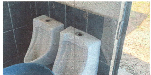
Foto 6: Sustitución de llave de mingitorio.
