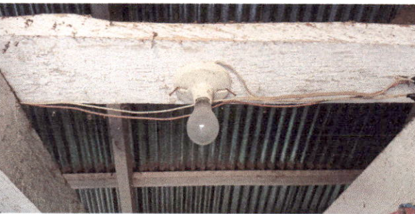
Foto 11: Sustrucción de cableado eléctrico sólido.
