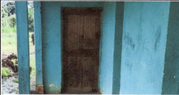
Foto 13: Fabricación e instalación de puertas de metal en módulos.
